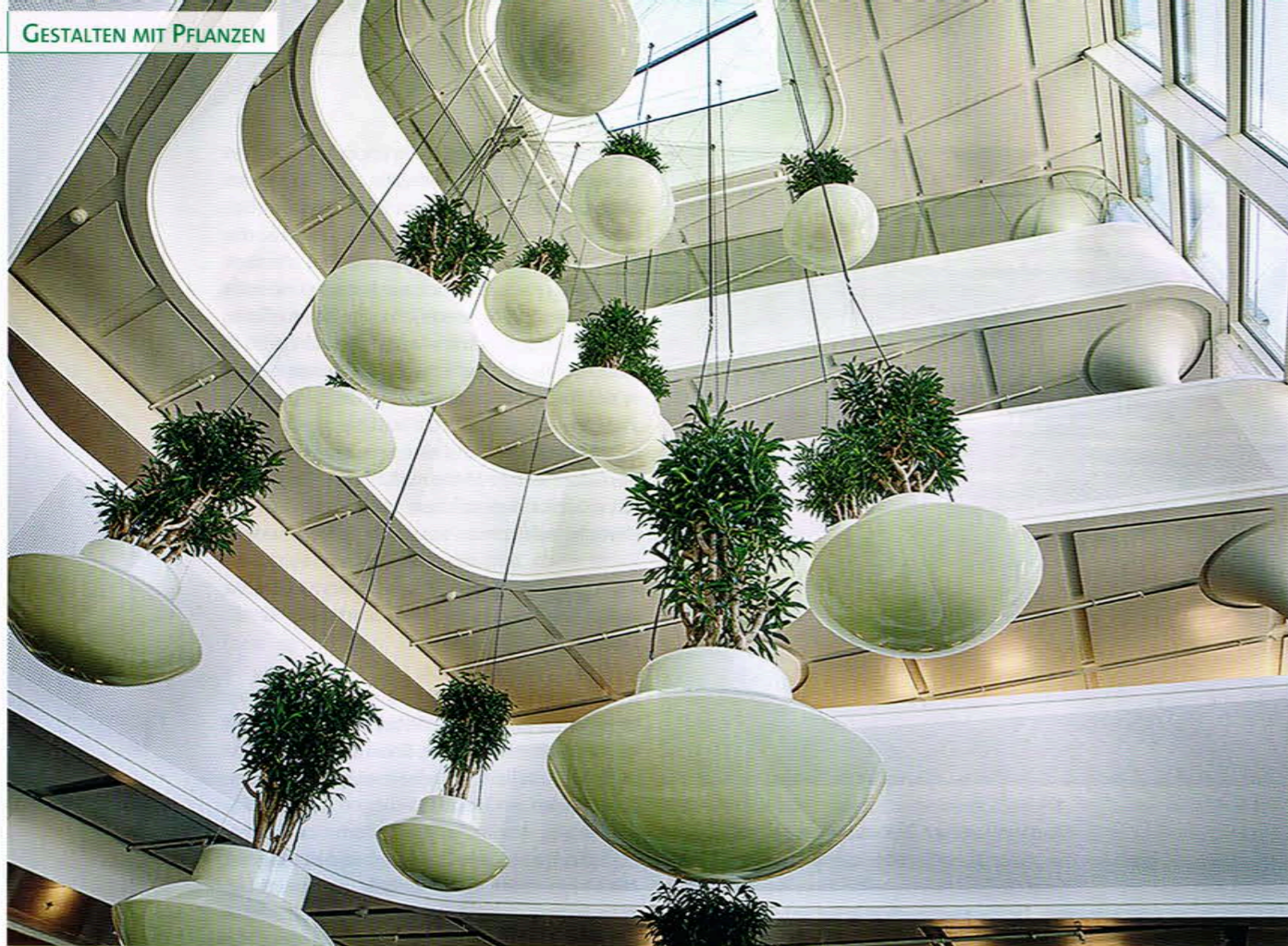
Die an Stahlseilen befestigten Pflanzschalen schweben in unterschiedlicher Höhe über mehrere Stockwerke verteilt. Werkfotos
